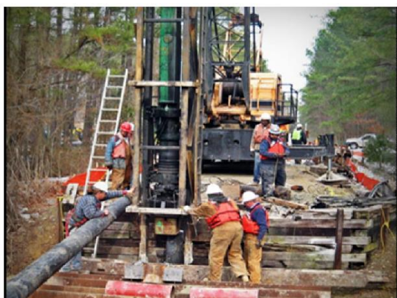
Рис. 4. Забивка свай и резка свай до заданной отметки – источник [2, 10]
