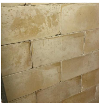
Рис. 4. Внутренняя перегородка из фосфогипсобетонных блоков
